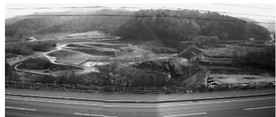
写真-1 全景（右岸側から）
