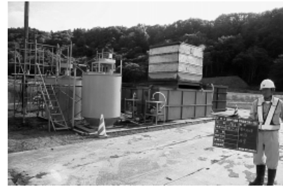
写真-2 濁水処理施設全景
