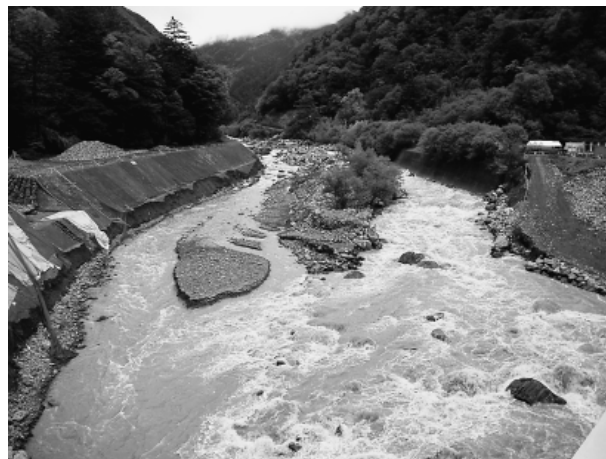
写真-4 台風18号による被災状況
