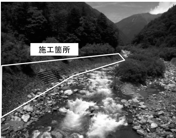
写真-1 工事箇所
