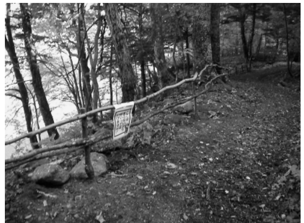
写真-7 転落防止柵
