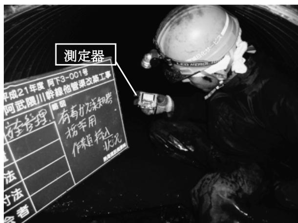
写真-5 管渠内酸欠硫化水素測定器携帯状況
