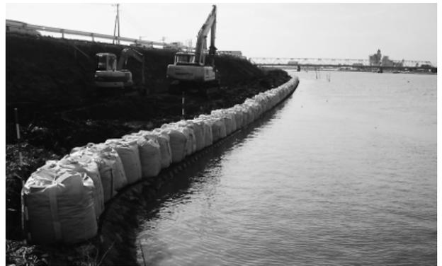
写真-2 工事用道路洗掘防止（大型土のう）
