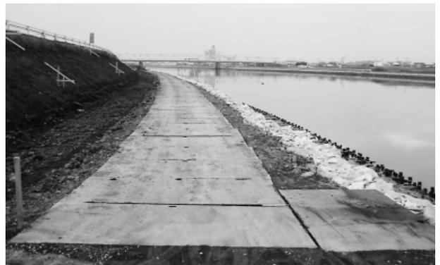
写真-3 工事用道路洗掘防止（敷鉄板）
