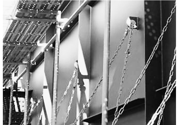
写真-6 錆安定化処理材の保護
