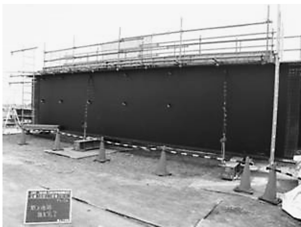
写真-1 桁上通路
