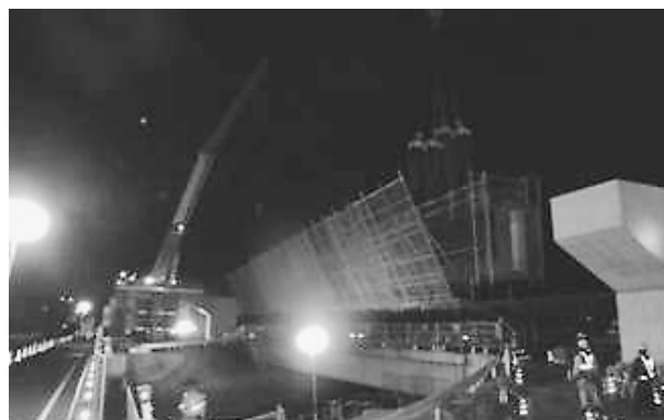
写真-3 朝顔足場の先行設置
