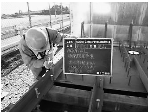
写真-9 高さ調整ボルト取り付け
