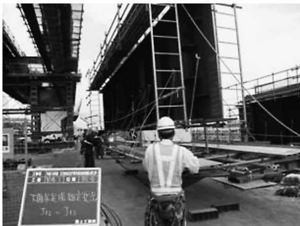
写真-2 下面足場の先行取付け
