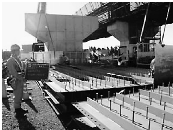
写真-10 側鋼板パネルの取付け
