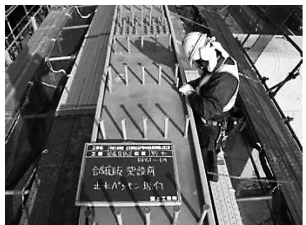
写真-7 合成床版施工に配慮した中段足場
