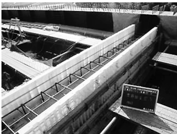
写真-8 樹脂型枠
