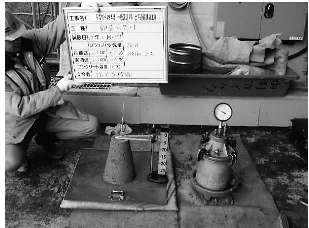
写真-2 外気温・コンクリート打設温度等確認
