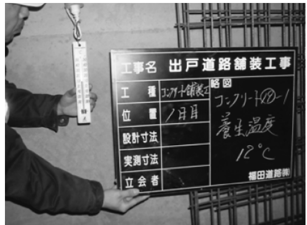
写真-3 坑内養生温度
