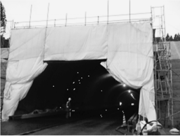
写真-4 坑口 防災シート仮囲い
