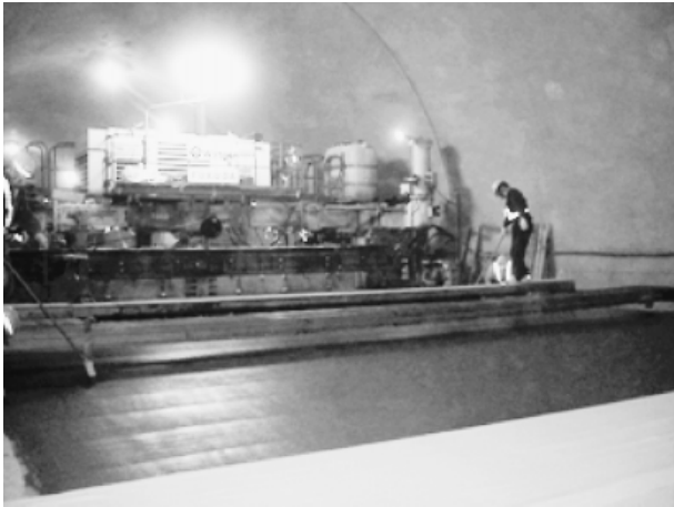
写真-1 スリップフォームペーバによる施工状況
