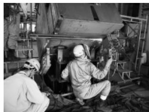
写真-3 Z継手溶接施工試験状況
