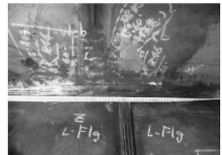
写真-5 Z継手溶接施工後の外観
