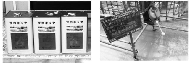
写真-4 初期乾燥ひび割れ防止（被膜養生剤使用）
