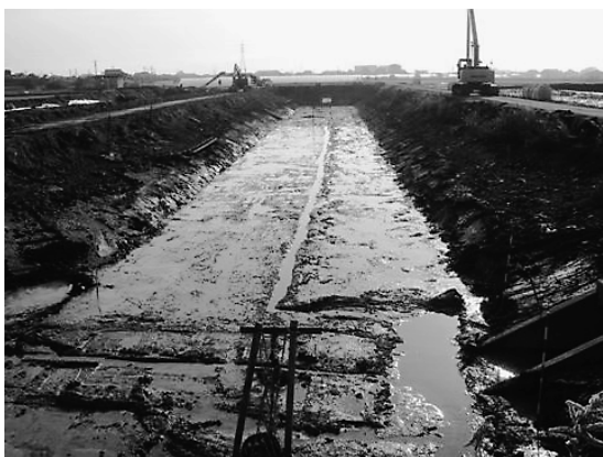
写真-5 ドライワーク施工の状況
