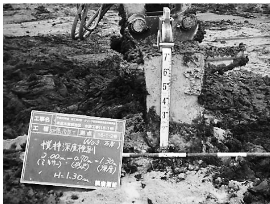
写真-7 深度管理バーによる確認
