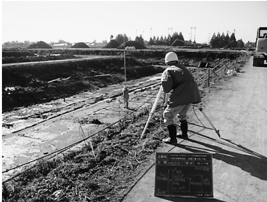
写真-11 塩ビ管設置高さ確認
