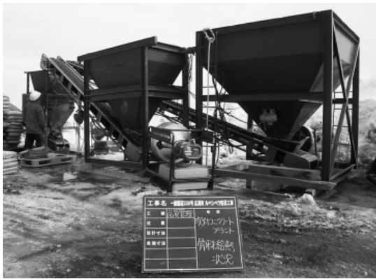
写真-2 骨材ホッパー 給熱状況
