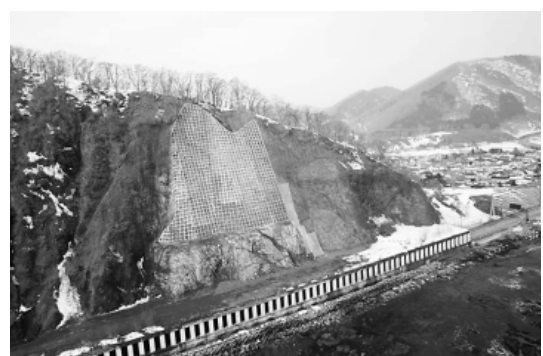
写真-1 施工箇所（完成写真）
