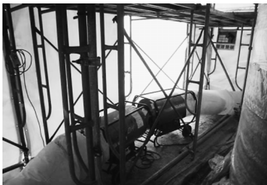
写真-2 給熱養生
