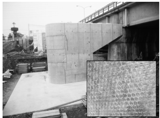
写真-3 気泡緩衝材による保温状況
