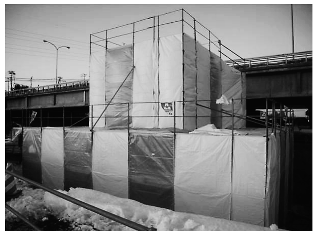
写真-1 防寒養生囲い
