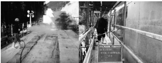
写真-11 散水・湿潤養生 写真-12 塗布型高性能収縮低減剤塗布
