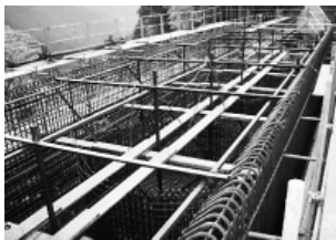
写真-4 組立鋼材
