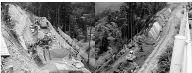
写真-2 アンカー施工状況 写真-3 深礎工・擁壁工施工状況
