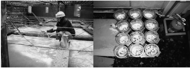
写真-7 原液散布 写真-8 現場条件と同等の2層に分けた圧縮試験供試体
