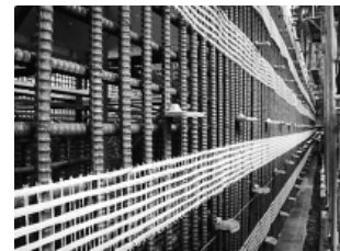
写真-6 壁部に耐アルカリ性ガラス繊維ネット
