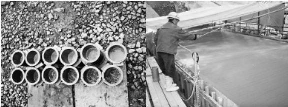
写真-9 引張試験供試体 写真-10 被膜養生剤散布
