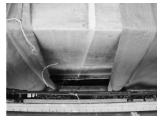
写真-5 打設後シーリング目地
