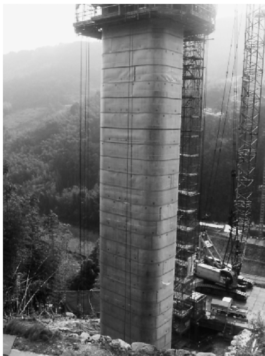
写真-4 躯体シート養生状況
