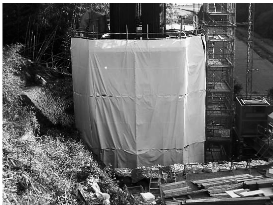
写真-2 養生状況
