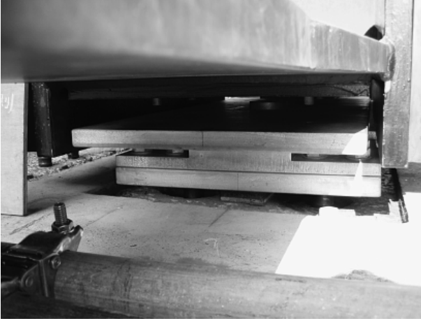
写真-6 水平沓ソールプレートと下沓の干渉
