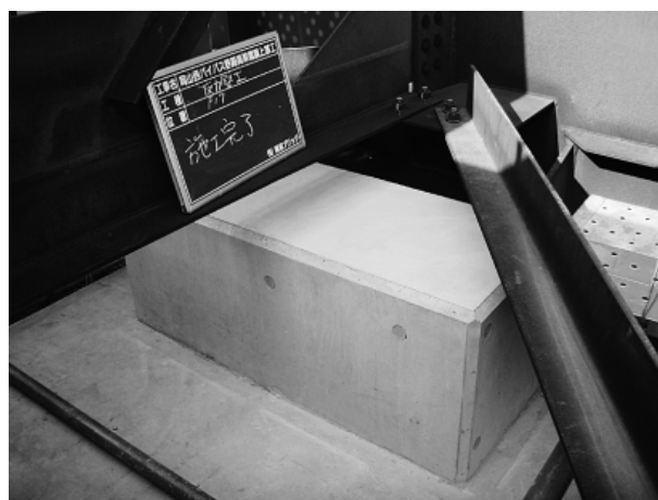
写真-5 反力壁施工完了
