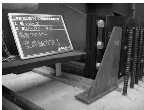
写真-4 バッファ固定金具取付位置
