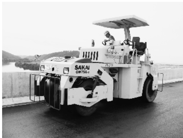
写真-5 二次転圧（振動タイヤローラ）
