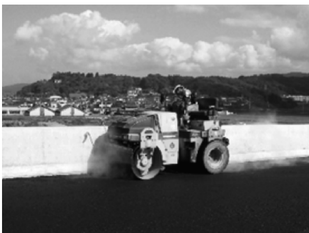
写真-8 橋梁端部の転圧（4tコンバインドローラ）
