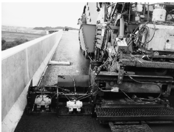
写真-7 橋梁端部の敷均し（テーパースクリード）
