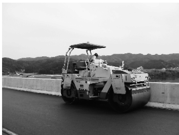
写真-6 仕上げ転圧（タンデムローラ）
