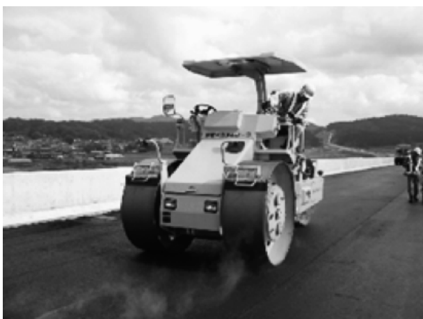
写真-4 初期転圧（振動マカダムローラ）
