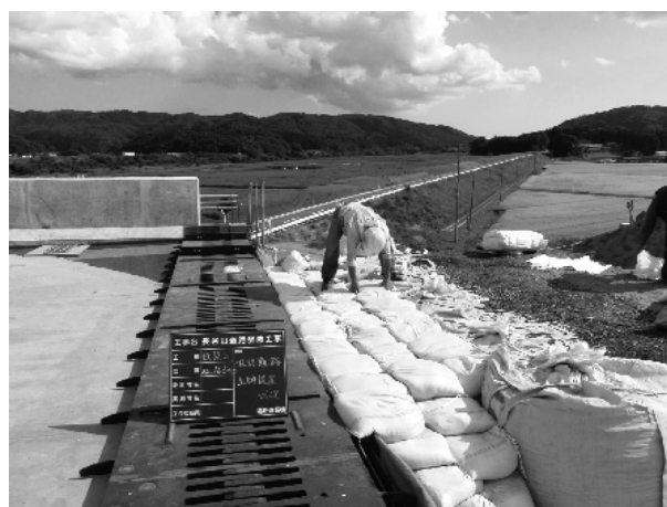
写真-3 橋梁部の仮設通路設置
