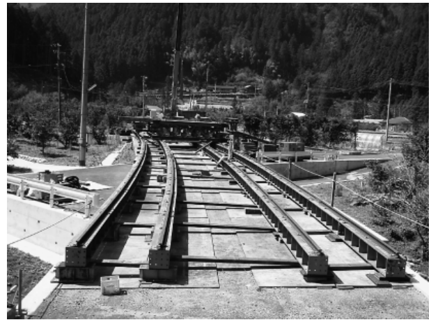
写真-1 送出し軌条設備
