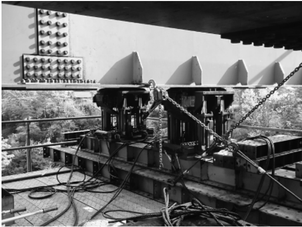
写真-5 エンドレスローラ設置状況
