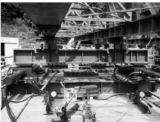
写真-2 水平ジャッキ受梁設置状況
