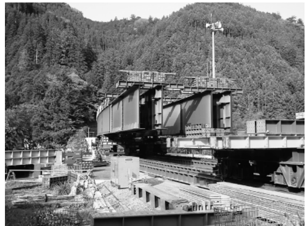
写真-6 後方ウェイト載荷状況
