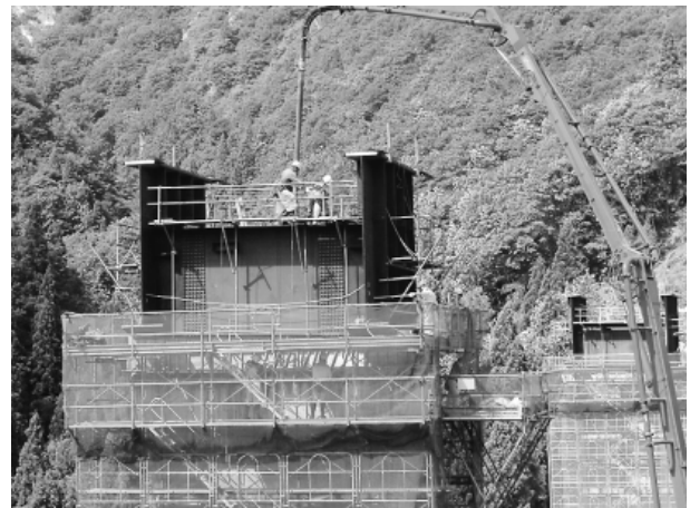
写真-2 剛結部施工状況
