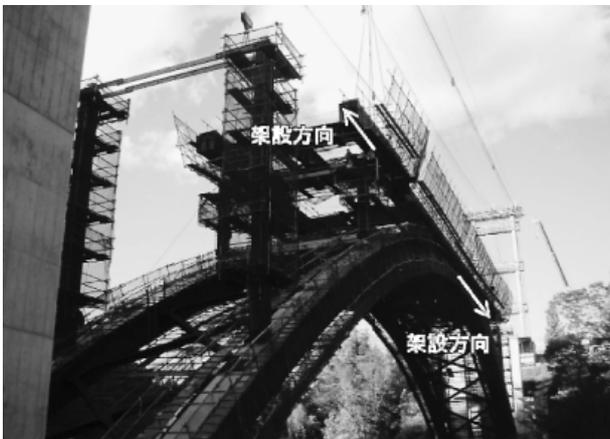
写真-5 補剛桁の架設状況
