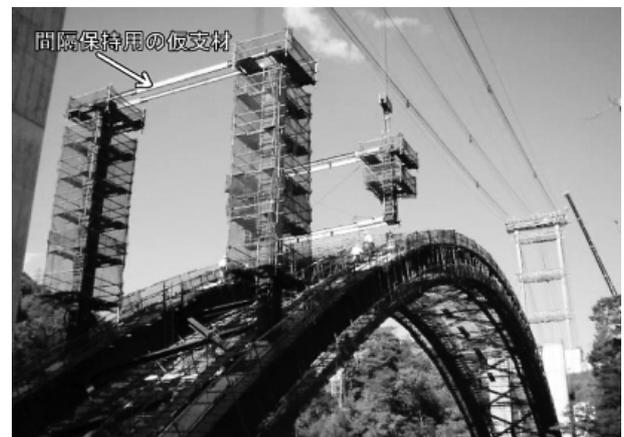
写真-4 支柱の架設状況
