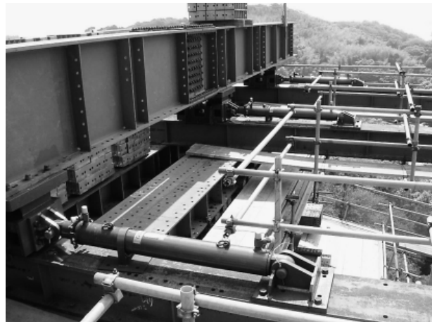
写真-1 橋脚上送出し設備
