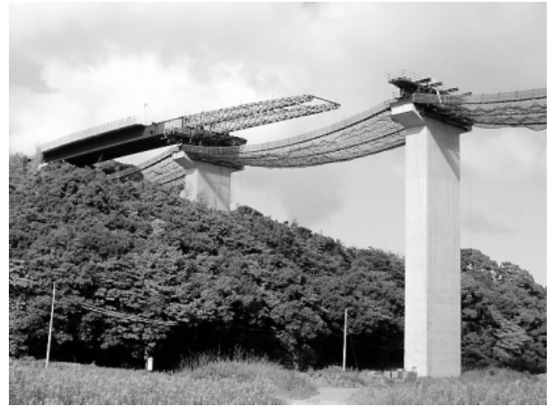
写真-5 送出し架設状況
