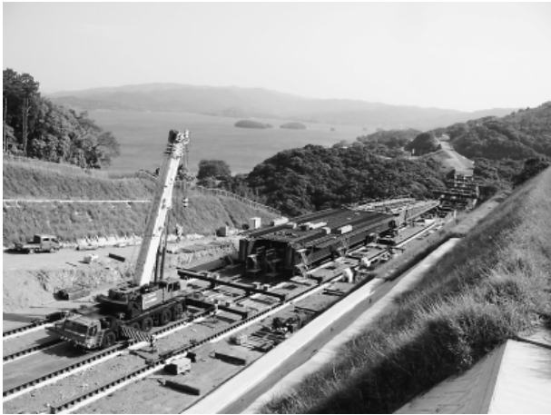
写真-4 送出し前合成床版架設完了
