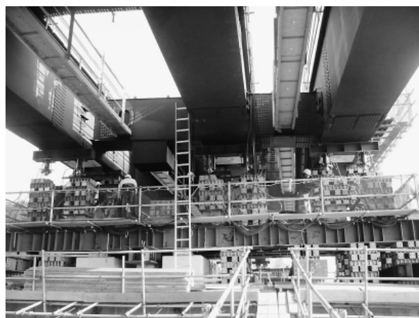
写真-3 桁降下状況
