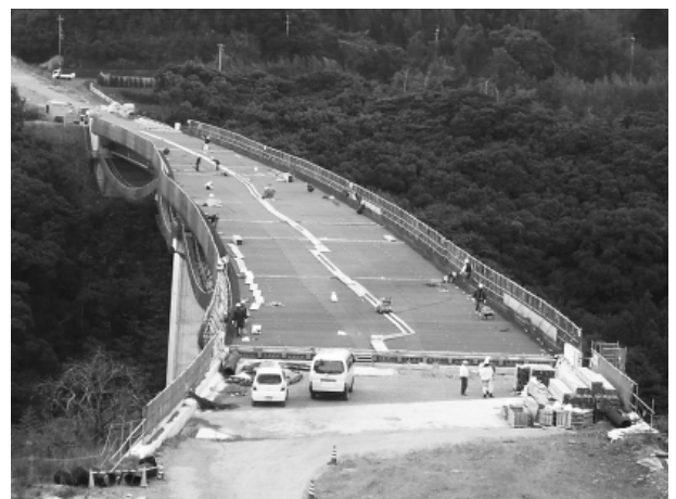
写真-6 桁送出し降下完了
