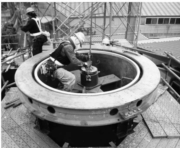
写真-4 柱内部(ピボット沓仮設置状況)
