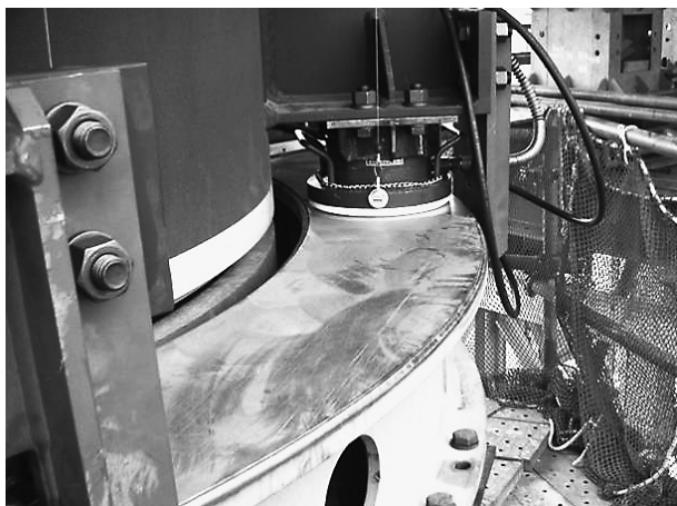
写真-5 柱外部(外周ジャッキ設置状況)
