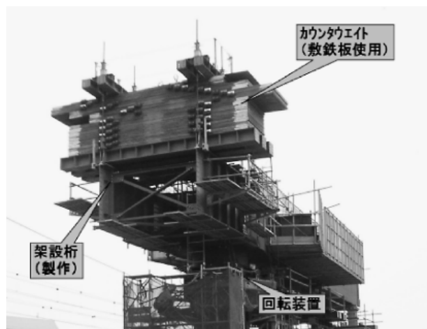
写真-2 設備組立完了（回転前）
