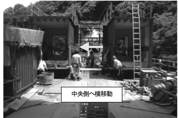
写真-3 横移動状況 (A2からA1を臨む 横移動完了)
