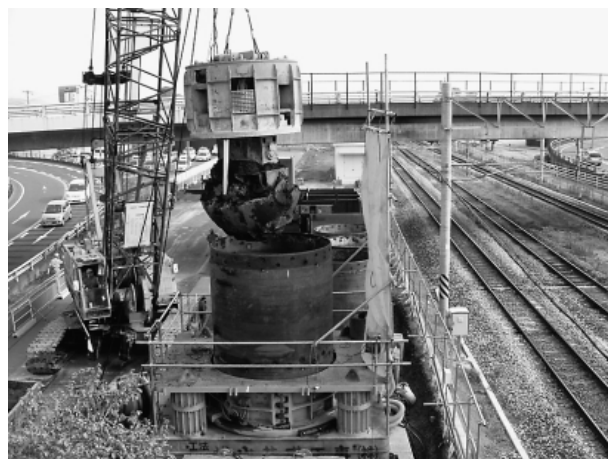
写真-1 場所打杭掘削状況
