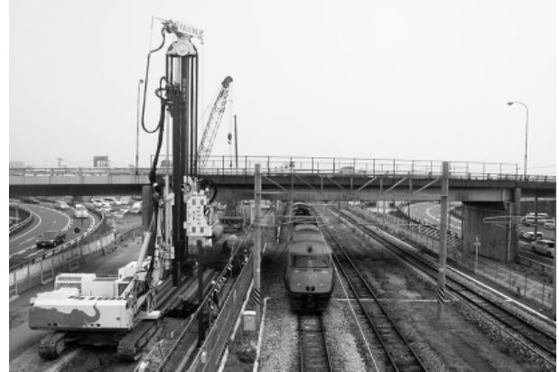
写真-4 鋼矢板振動圧入状況
