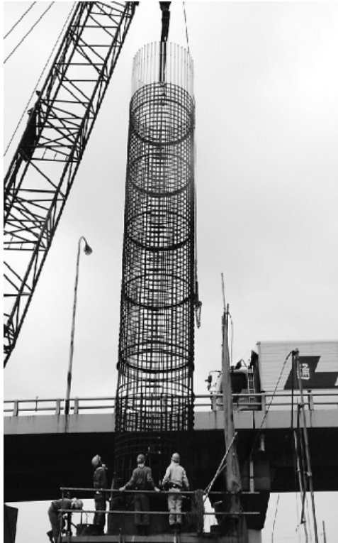
写真-3 鉄筋籠設置状況
