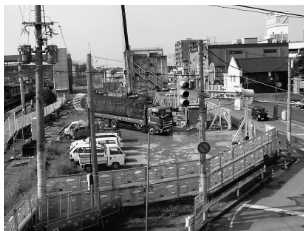
写真-2 鉄筋籠作成運搬
