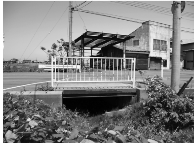
写真-2 施工前（既設）
