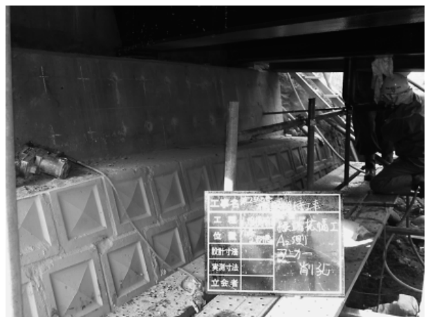
写真-1 アンカー削孔
