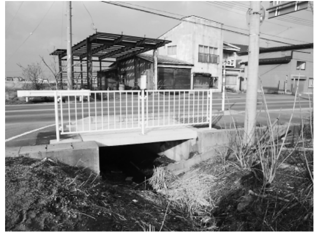
写真-5 施工後(PC床版)
