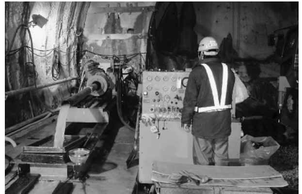
写真-3 シールドリバースボーリング状況
