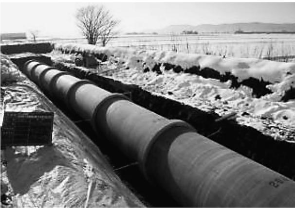
写真-4 管路曲線設置状況
