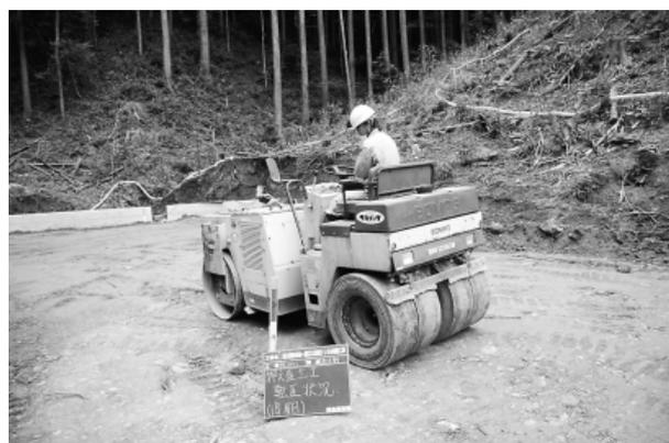
写真-7 押え盛土施工状況
