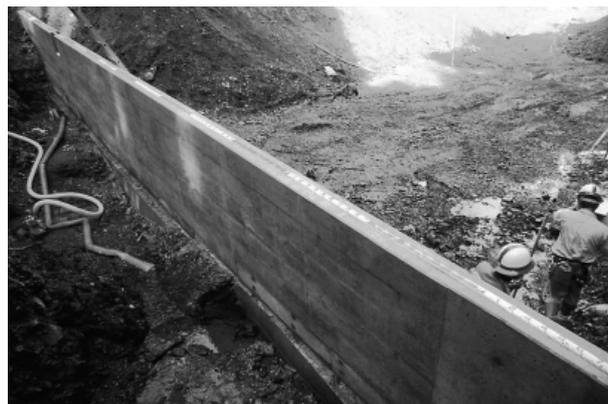
写真-6 止水壁構築状況
