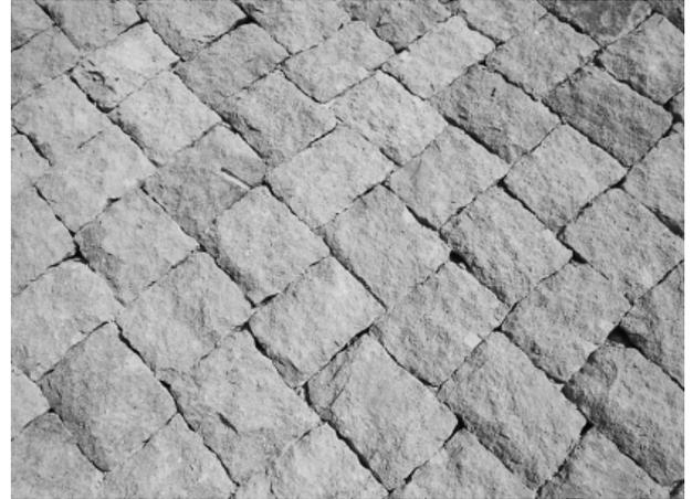
写真-3 川表高水護岸の石積み
