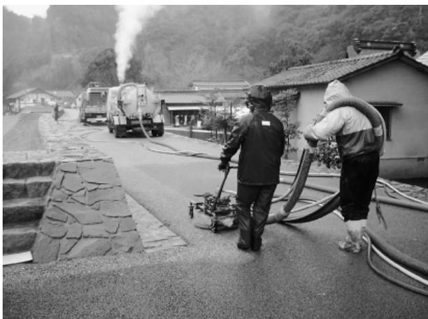
写真-10 ウォータースラスト施工状況
