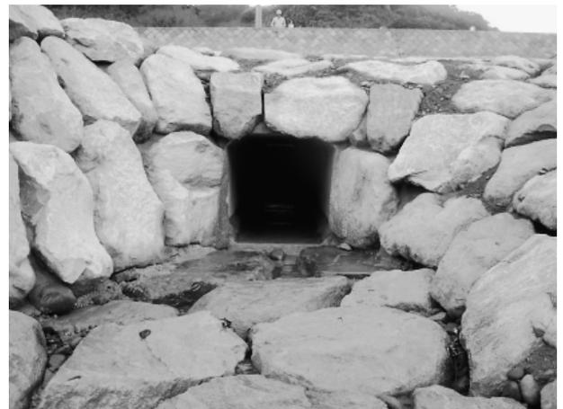
写真-8 樋管流末部の端部処理状況
