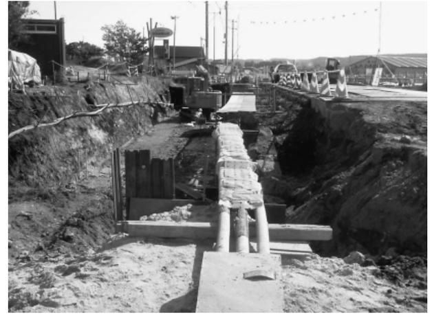
写真-2 NTTケーブル移設完了
