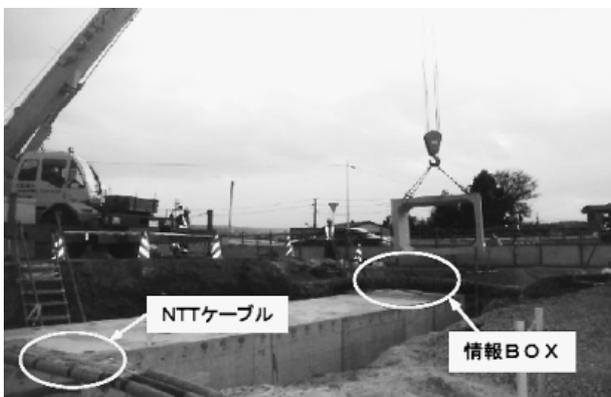
写真-3 オープン掘削による施工状況
