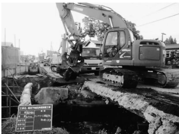
写真-6 圧碎機による取壊し状況
