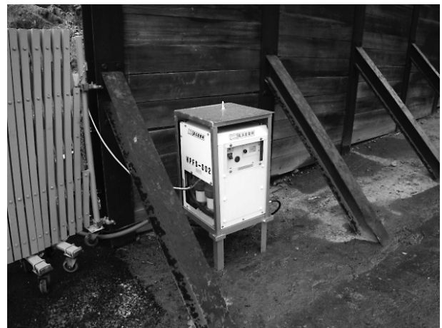
写真-3 ポンプユニット設置状況
