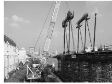
写真-3 桁(アーチ)組立状況
