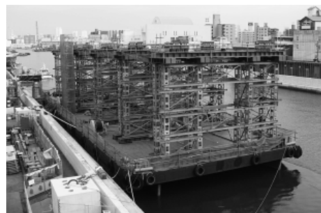
写真-2 ベント設置状況
