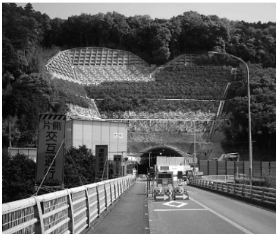
写真-1 発進側坑口正面
