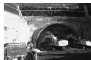
写真-3 掘削状況
