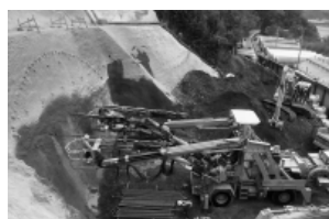
写真-2 FIT ボルト施工状況
