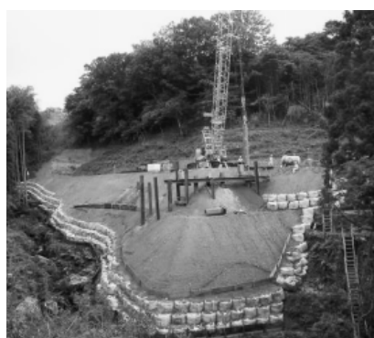
写真-4 ダウンザホール掘削状況
