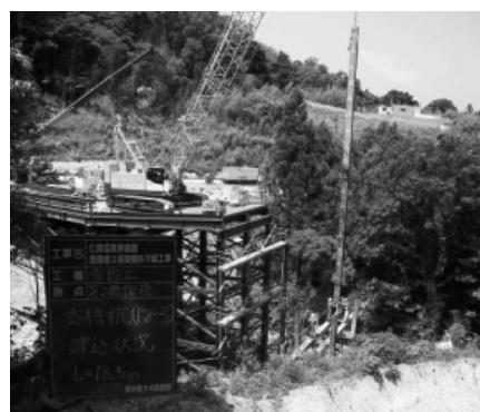
写真-5 支持杭建込み状況
