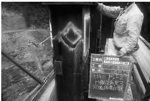
写真-3 支持杭の溶接による継足し
