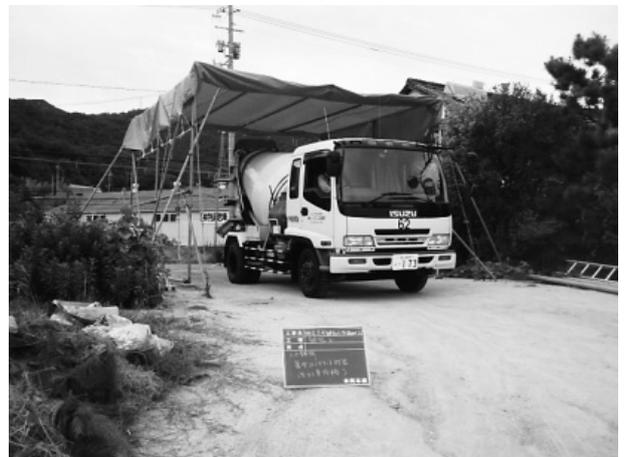
写真-1 暑中対策（屋根付き待機所設置）
