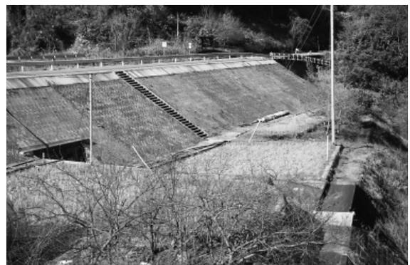
写真-3 保水型ブロック施工箇所
