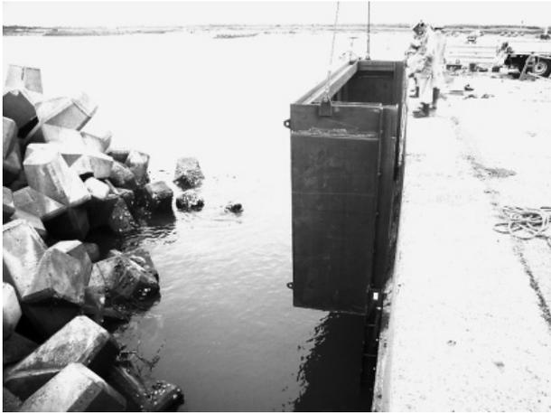
写真-3 仮締切函体取付け状況
