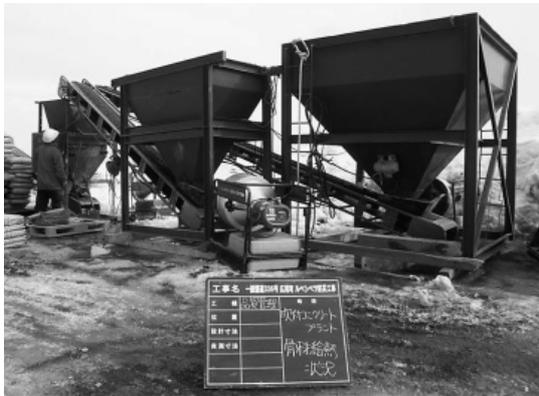
写真-2 骨材ホッパー 給熱状況
