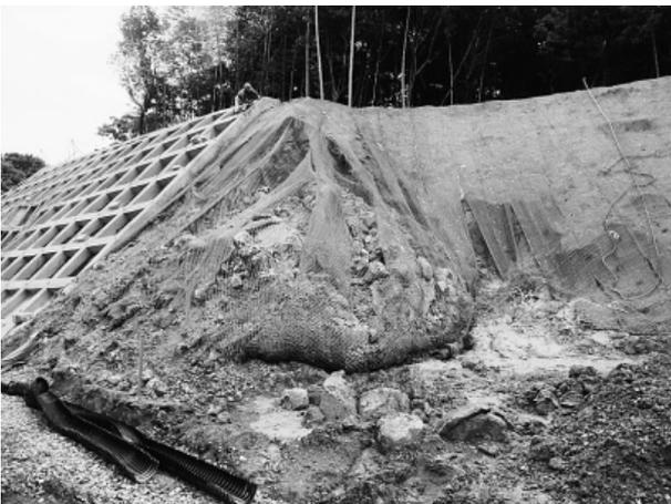
写真-1 法面崩落状況
