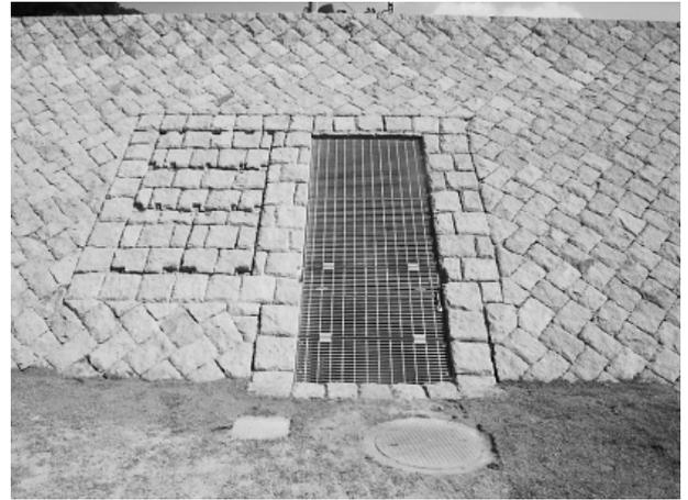
写真-7 樋管機械室の格納状況
