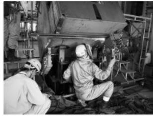
写真-3 Z継手溶接施工試験状況
