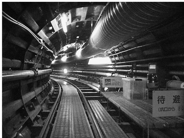
写真-4 急曲線部の注意喚起装置
