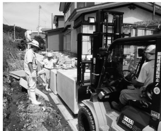
写真-3 ボックスカルバート据付け状況
