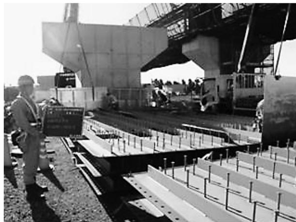
写真-10 側鋼板パネルの取付け
