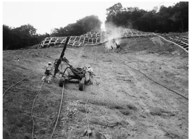
写真-4 ロックボルト工削孔状況
