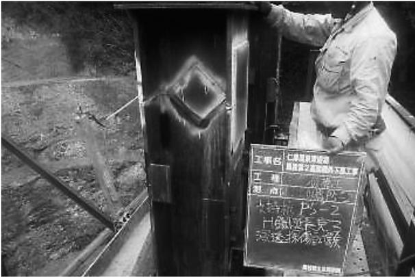
写真-3 支持杭の溶接による継足し
