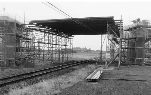
写真-2 防護工施工完了
