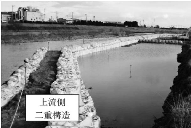
写真-4 仮締切り設置完了写真
