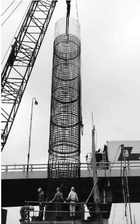
写真-3 鉄筋籠設置状況
