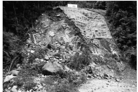
写真-1 岩盤崩落後の状況
