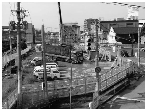
写真-2 鉄筋籠作成運搬
