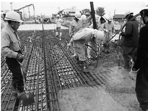
写真-1 コンクリート打設状況
