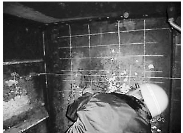
写真-2 端横桁の変状量調査
