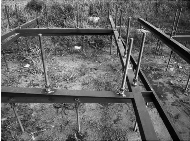
写真-1 ボルト取付状況
