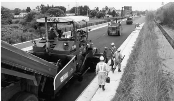
写真-1 大型アスファルトフィニッシャ
