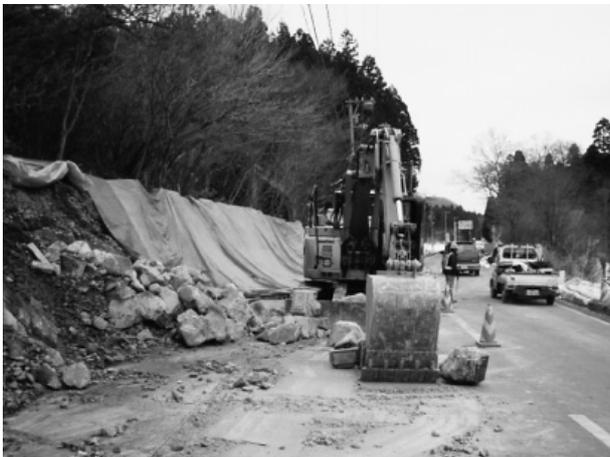
写真-1 被災箇所への撤去状況
