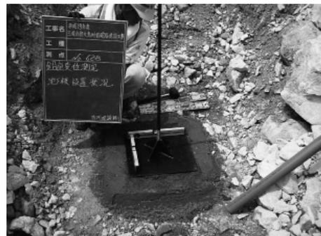
写真-4 沈下板設置状況
