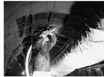
写真-3 充填モルタルの吹付け状況
