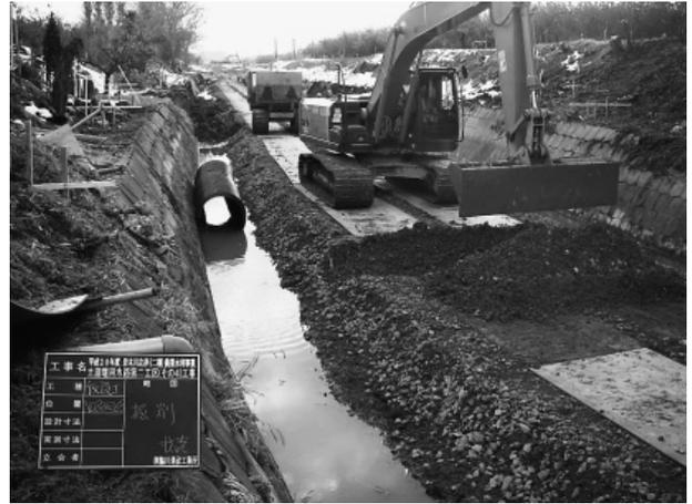
写真-1 耐圧ポリエチレン管φ1,000mm
