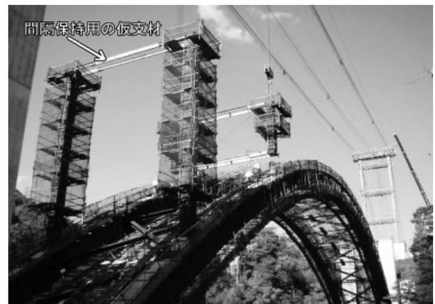
写真-4 支柱の架設状況
