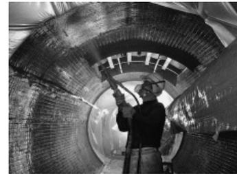
写真-4 耐硫酸モルタルの吹付け状況
