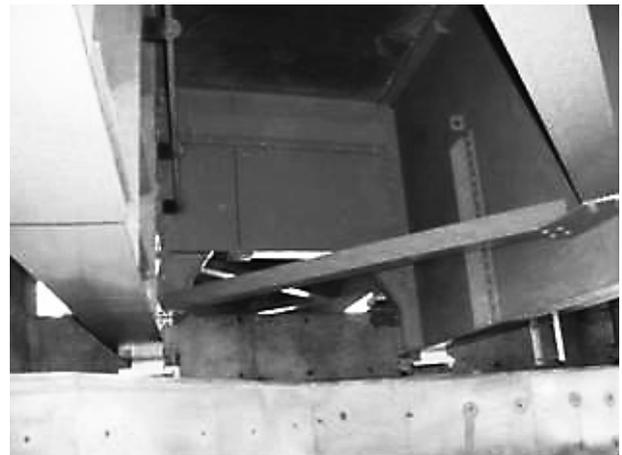
写真-5 端横桁・横構補修の完了状況
