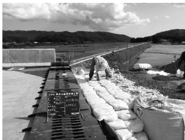
写真-3 橋梁部の仮設通路設置
