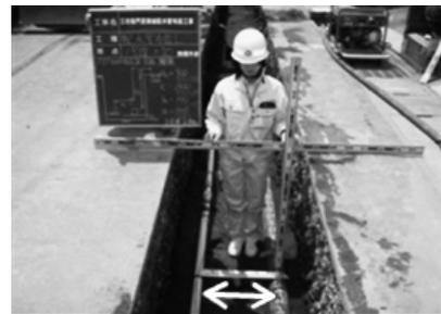
写真-5 新設ガス管との離隔
