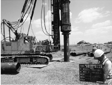
写真-2 導材を使用した鋼管杭打込み
