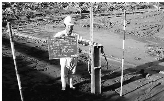
写真-9 サンプラーの残尺検測
