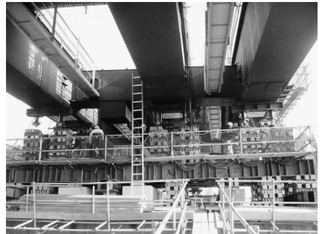
写真-3 桁降下状況
