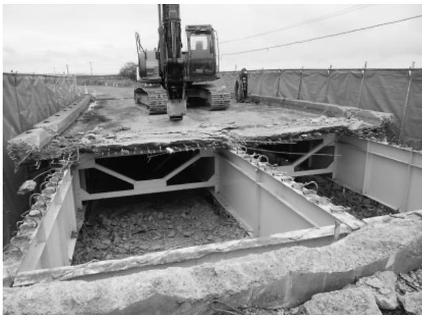
写真-5 桁下板張防護
