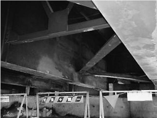
写真-1 火災した本橋の損傷状況
