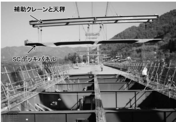
写真-6 SCデッキパネル架設状況
