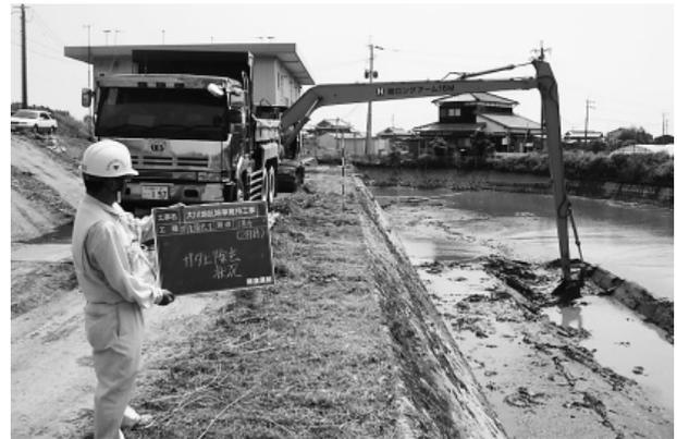
写真-8 バックホウによる掘削
