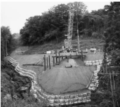
写真-4 ダウンザホール掘削状況
