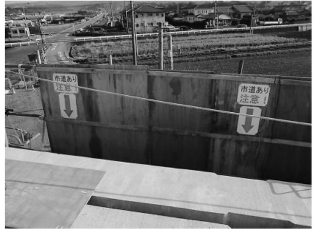
写真-7 飛散防止用合板設置
