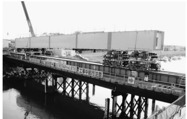
写真-1 桁縦送り状況
