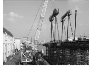
写真-3 桁(アーチ)組立状況
