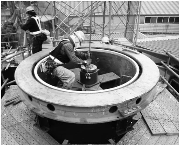
写真-4 柱内部(ピボット脊仮設置状況)
