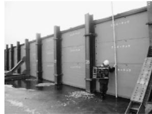
写真-2 仮締切堤内側
