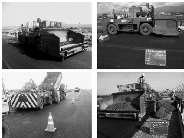
写真-3 ロードワイドナでの施工状況
