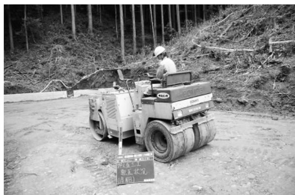
写真-7 押え盛土施工状況
