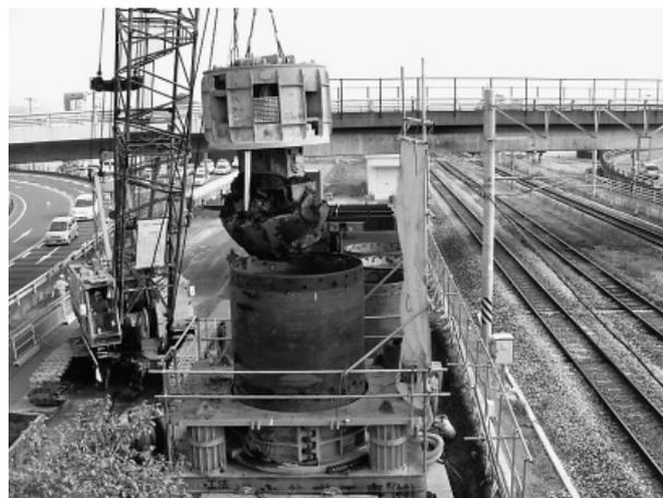
写真-1 場所打杭掘削状況
