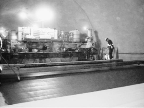
写真-1 スリップフォームペーパーによる施工状況
