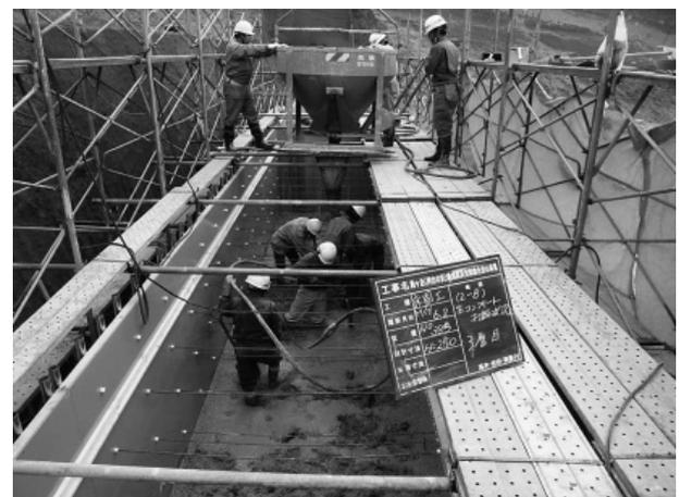
写真-2 3層目打設設況
