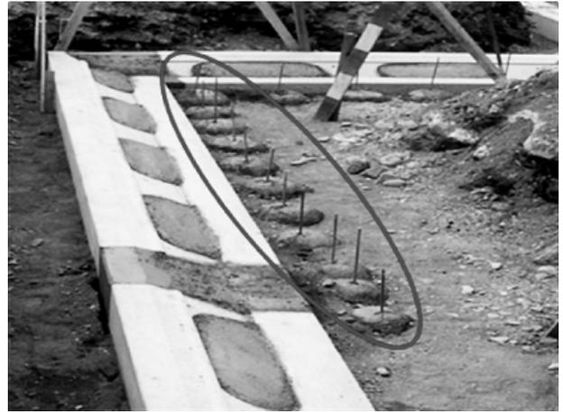
写真-1 コンクリート・差し筋（D13）
