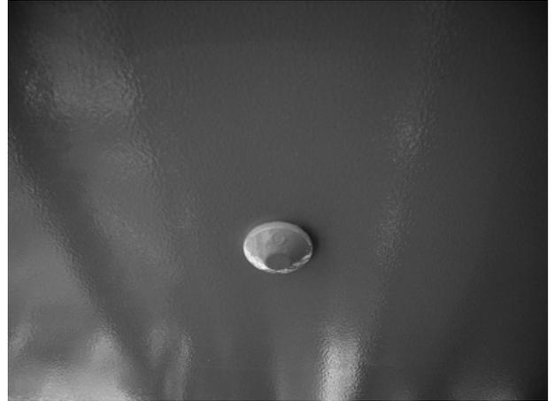
写真-4 閉ボルト塗装
