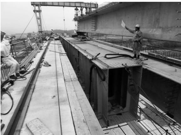
写真-2 架設桁移動状況
