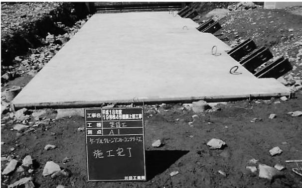
写真-2 ケーブルアンカーコンクリート施工状況
