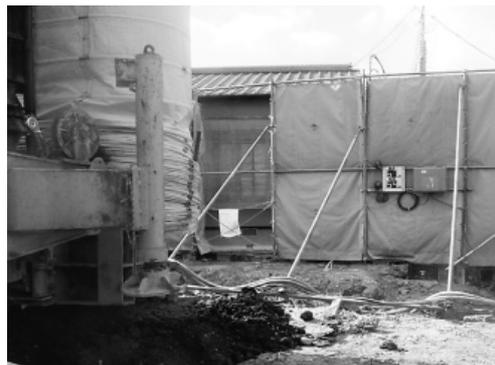
写真-5 防音シート柵と外部表示盤
