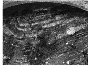
写真-1 砂岩頁岩互層/過褶曲構造
