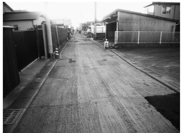
写真-3 路面切削完了
