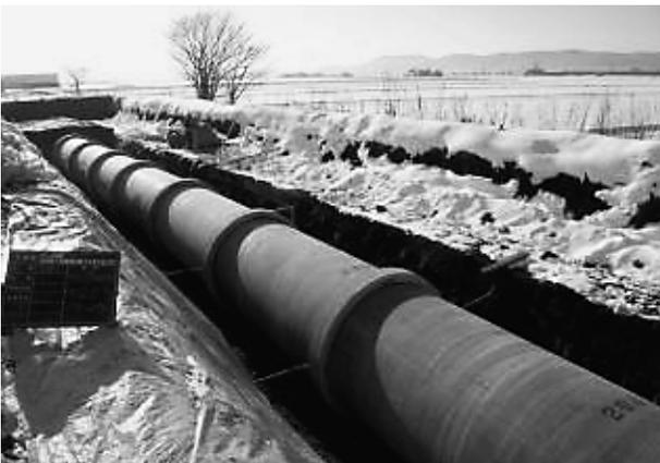
写真-4 管路曲線設置状況
