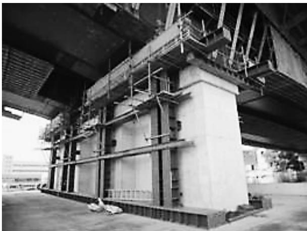
写真-2 仮受設備設置状況
