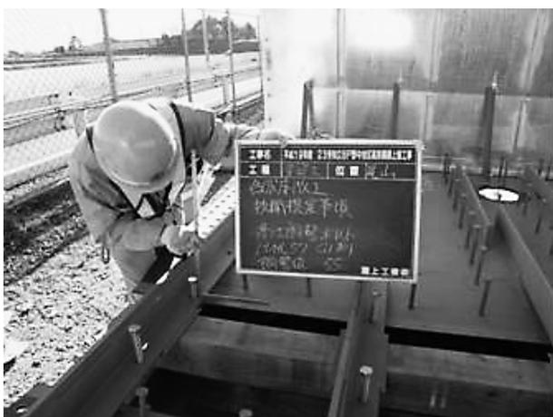
写真-9 高さ調整ボルト取り付け
