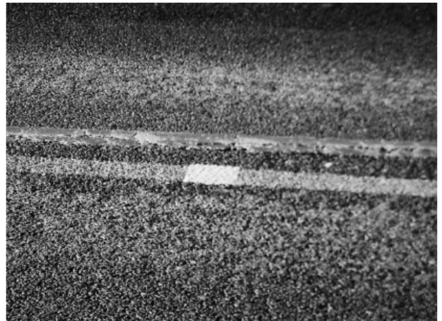
写真-4 高輝度反射テープ設置
