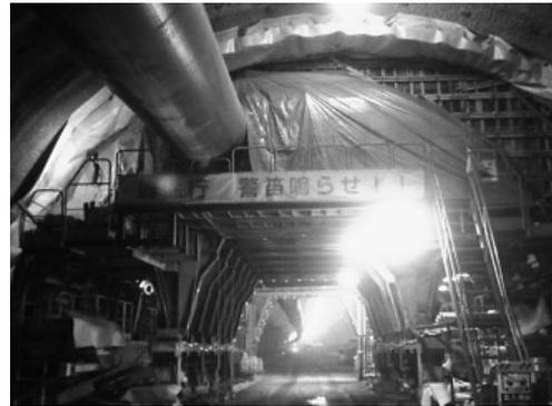
写真-8 シートによるセントルの保温養生
