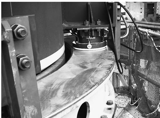
写真-5 柱外部(外周ジャッキ設置状況)
