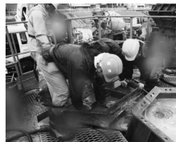
写真-6 型枠蓋設置状況
