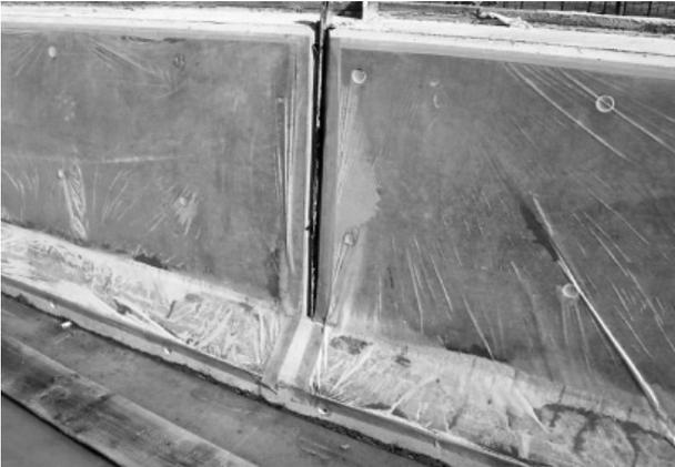
写真-2 封緘養生状況（脱枠後から1週間）
