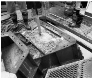
写真-2 バイブレーター締固め状況
