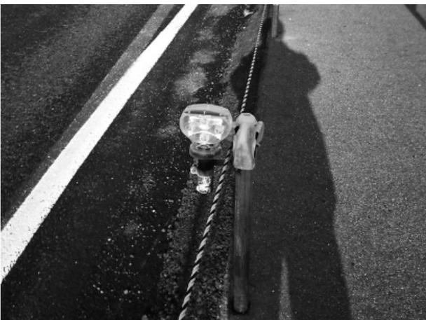
写真-3 下り線側自発光視線誘導標設置
