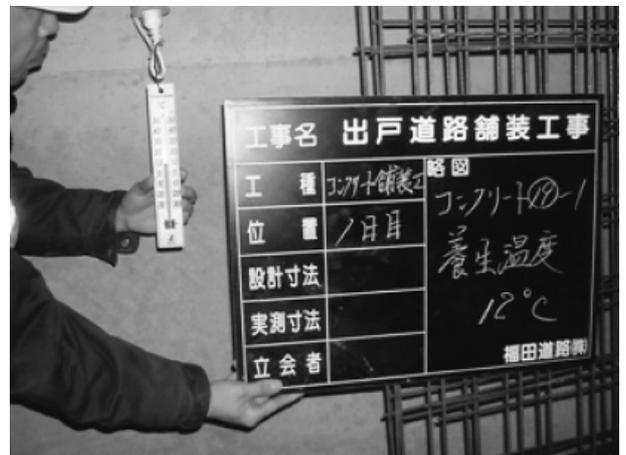
写真-3 坑内養生温度
