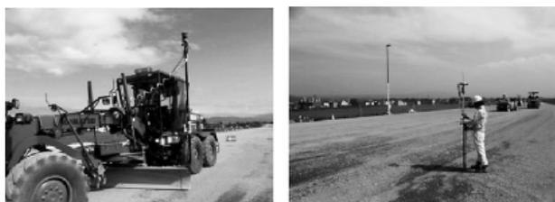
写真-2 自動制御による施工状況
