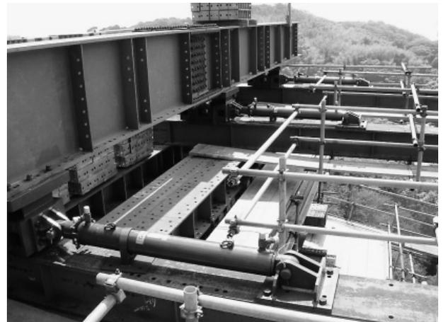
写真-1 橋脚上送出し設備
