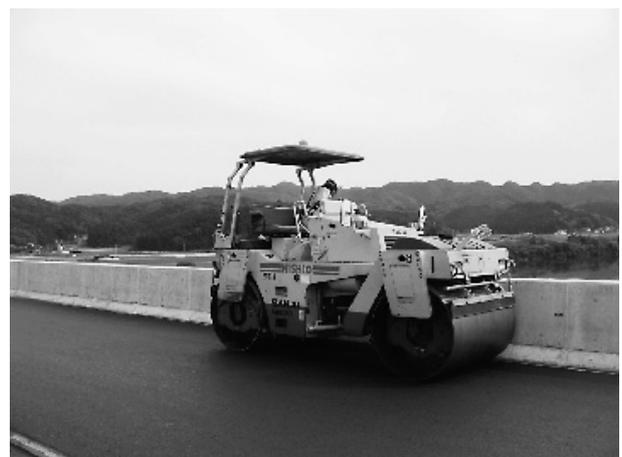
写真-6 仕上げ転圧（タンデムローラ）
