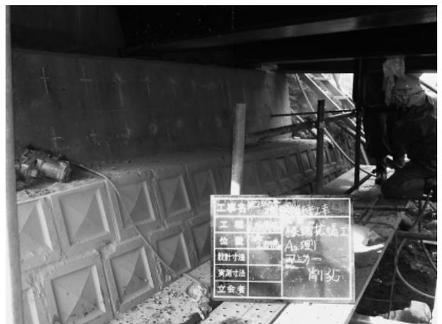
写真-1 アンカー削孔
