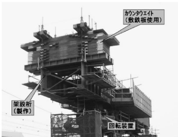
写真-2 設備組立完了（回転前）
