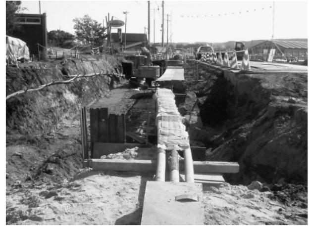
写真-2 NTTケーブル移設完了
