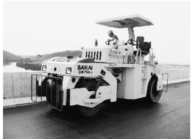
写真-5 二次転圧（振動タイヤローラ）
