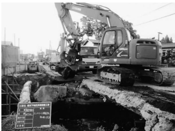
写真-6 圧砕機による取壊し状況
