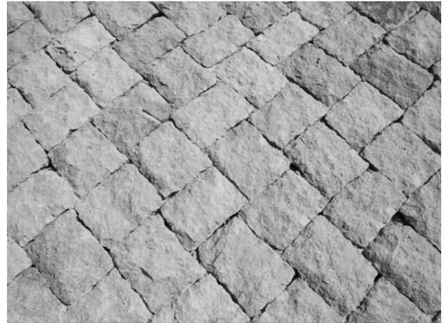
写真-3 川表高水護岸の石積み
