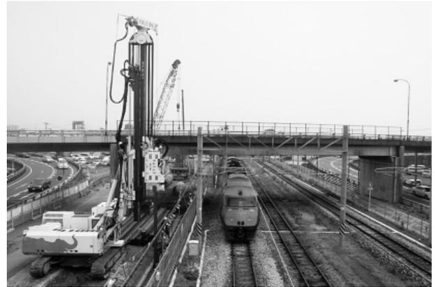
写真-4 鋼矢板振動圧入状況
