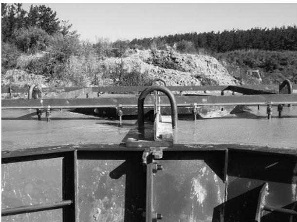
写真-2 ボルト埋込状況
