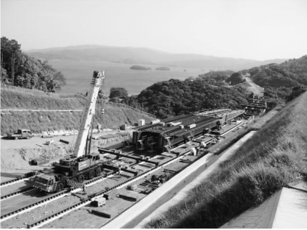
写真-4 送出し前合成床版架設完了
