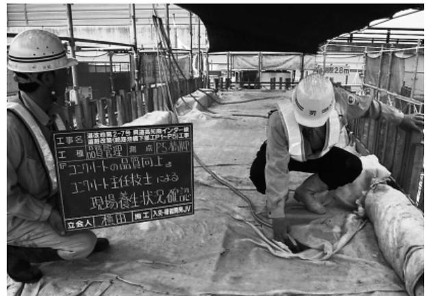
写真-5 パイプクーリングによる温度抑制状況
