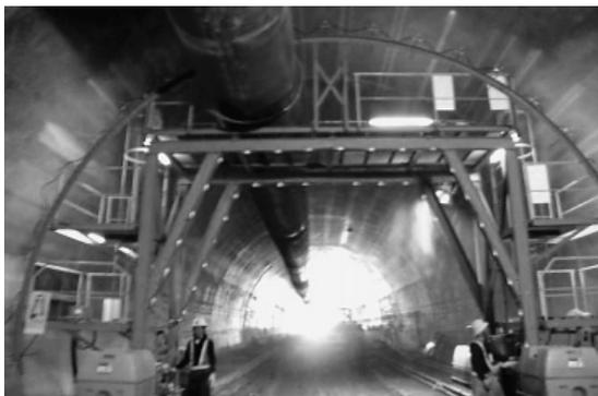
写真-7 被膜養生剤の散布（噴霧台車使用）
