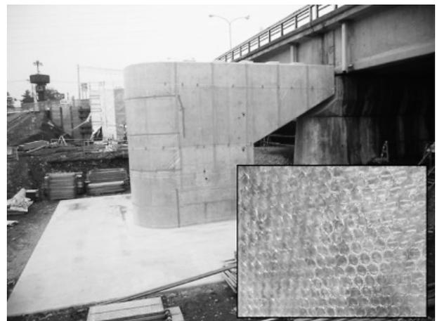
写真-3 気泡緩衝材による保温状況
