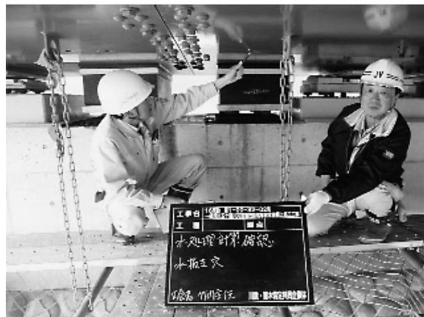
写真-3 水抜き主穴
