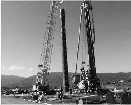
写真-1 鋼管ソイルセメント杭造成中
