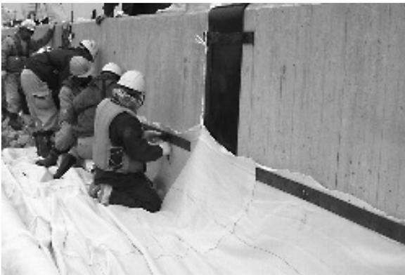
写真-1 シート端部の固定状況
