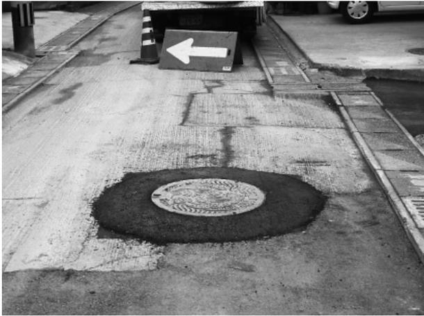
写真-1 擦り付け舗装
