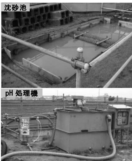
写真-4 沈砂池とpH処理機
