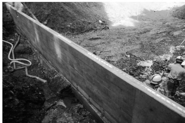
写真-6 止水壁構築状況
