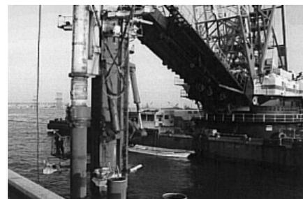
写真-1 鋼管杭打込み状況
