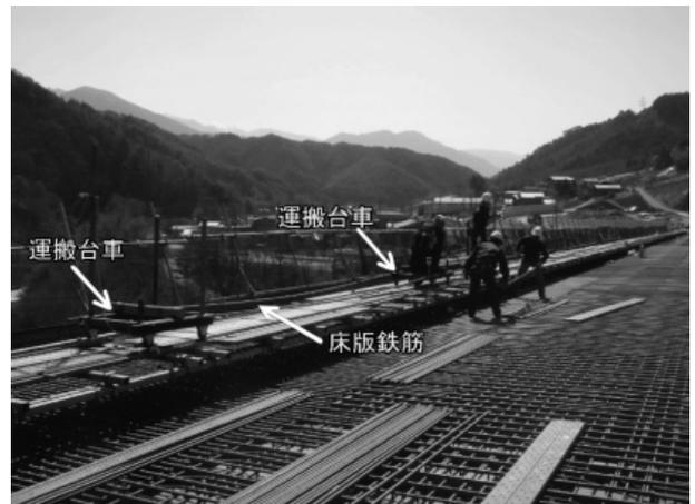
写真-7 レール式台車による運搬作業状況
