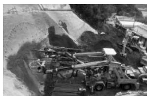
写真-2 FIT ボルト施工状況
