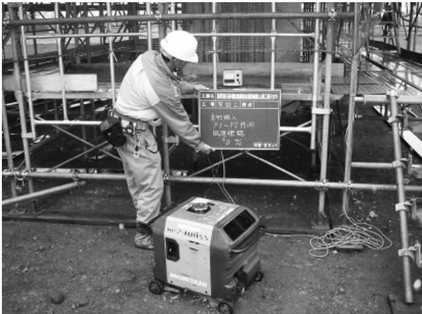
写真-5 警報装置付風速計
