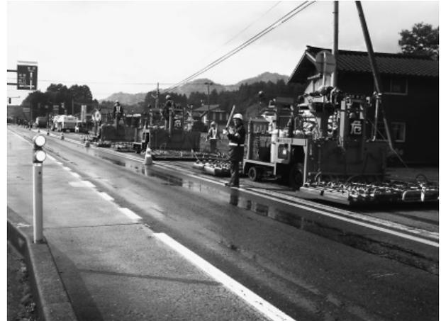
写真-1 路面加熱（路面ヒーター車）
