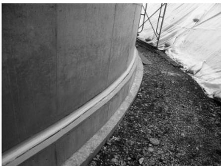
写真-1 ウレタン系防水材料塗布完了
