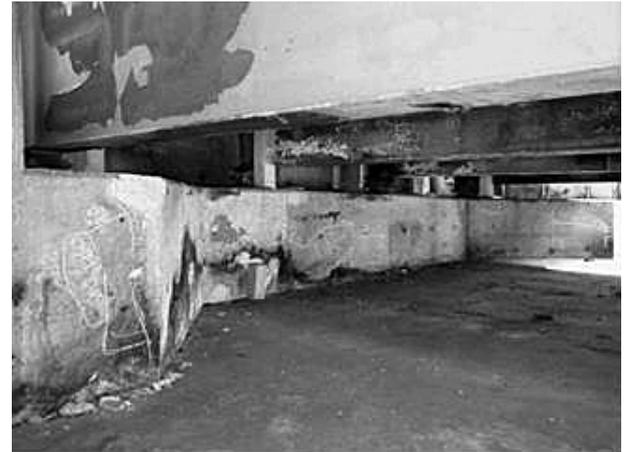
写真-4 橋脚コンクリートの損傷状況
