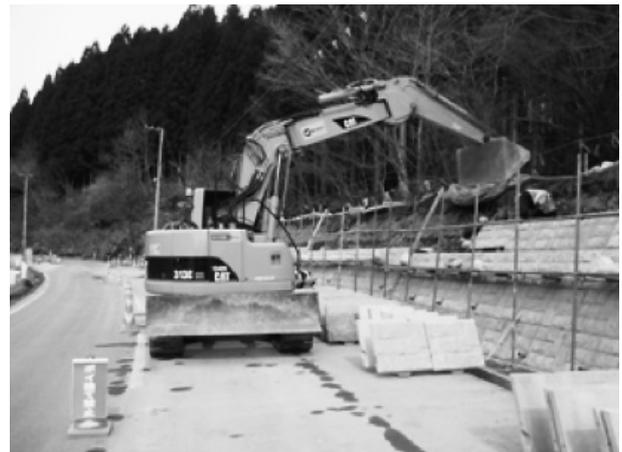
写真-2 大型ブロック積工の施工状況
