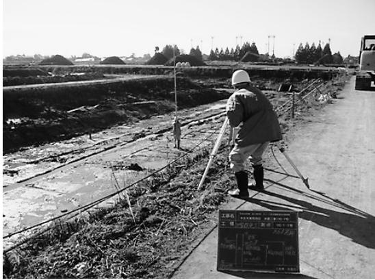
写真-11 塩ビ管設置高さ確認
