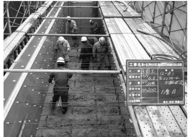
写真-1 1層目打設設況
