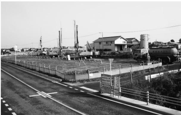
写真-2 地盤改良施工中
