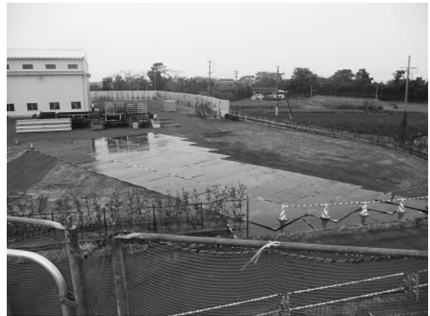
写真-3 搬入路鉄板敷込み完了
