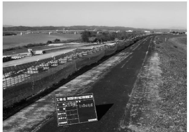
写真-2 立入禁止柵設置写真
