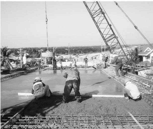
写真-2 コンクリート打設状況
