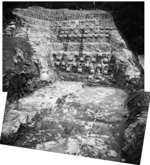
写真-6 抑止工、床掘り完了状況
