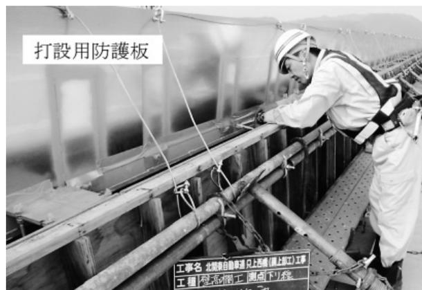
写真-3 打設用防護板（固定）
