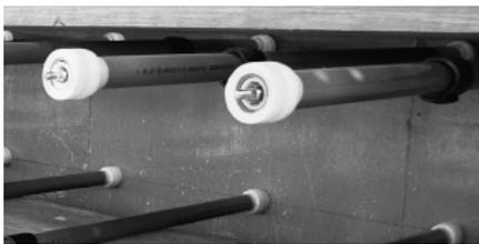
写真-1 被覆したセパレーター
