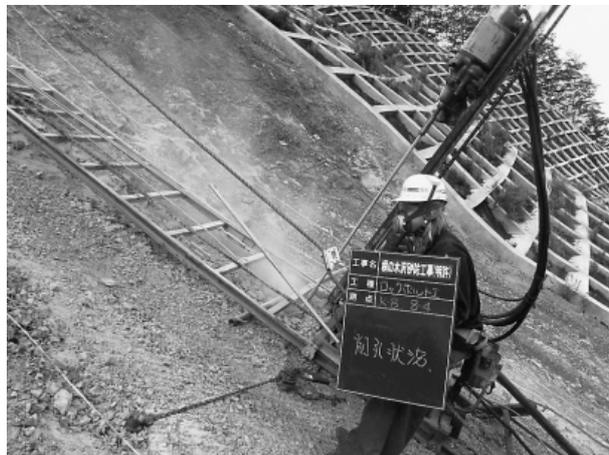
写真-2 梯子式クライマードリル施工状況
