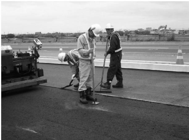
写真-3 タンパ締め固め状況
