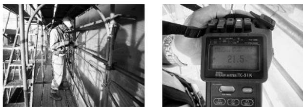
写真-2 内部温度測定状況
