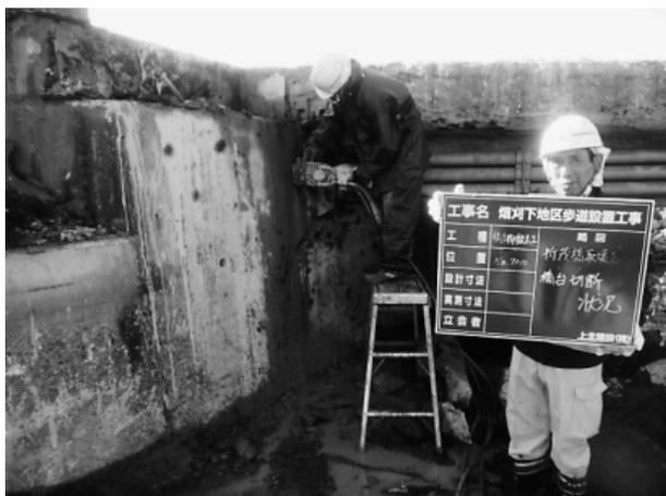
写真-5 躯体チェーンソー切断状況
