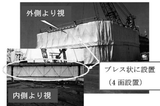
図-5 潮流対策構造の汚濁防止枠
