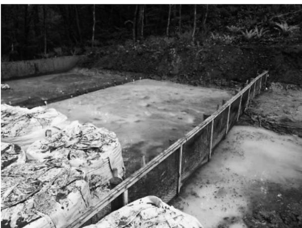
写真-5 仮設沈砂池
