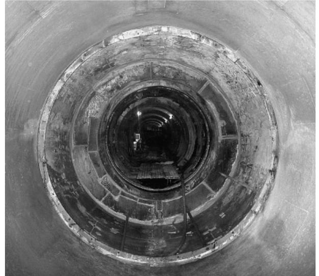
写真-6 シールド接続完了（フロア⑪）
