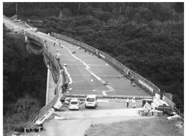
写真-6 桁送出し降下完了
