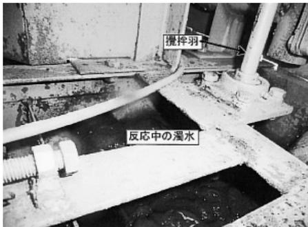
写真-4 攪拌槽内部
