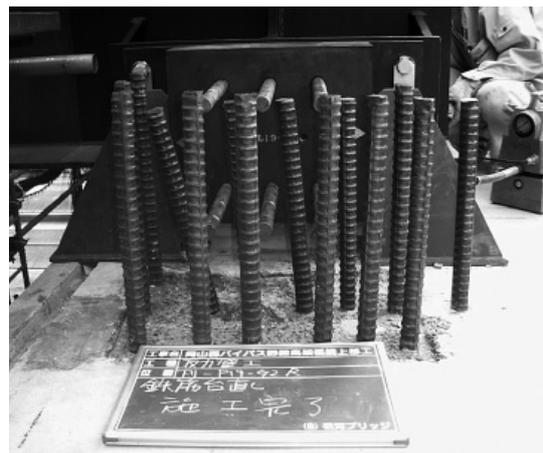
写真-2 鉛直鉄筋の曲げ加工
