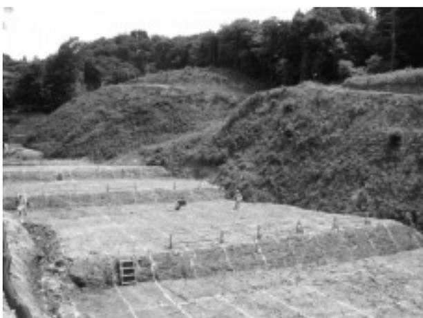
写真-2 施工基面整形後
