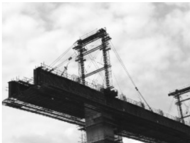
写真-1 施工状況
