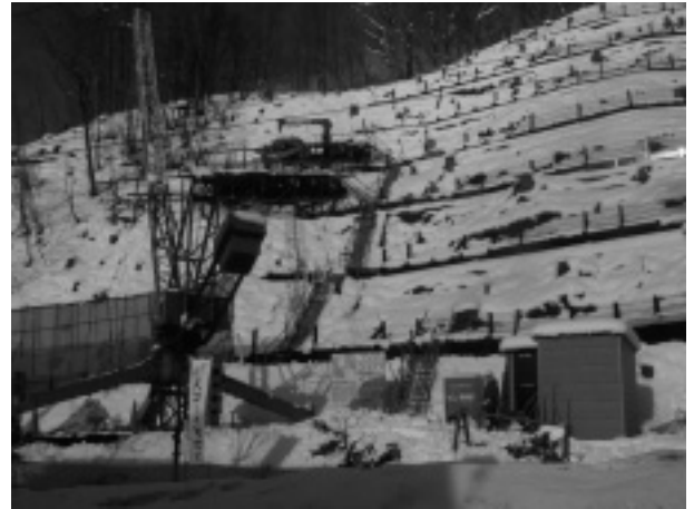
写真-2 施工現場
