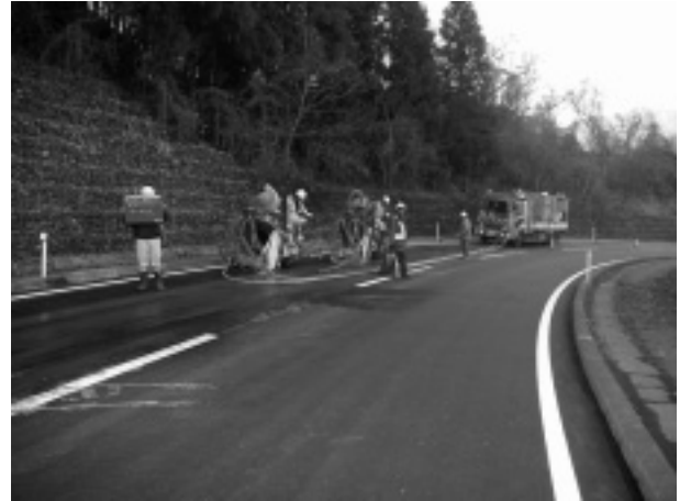
写真-1 施工状況
