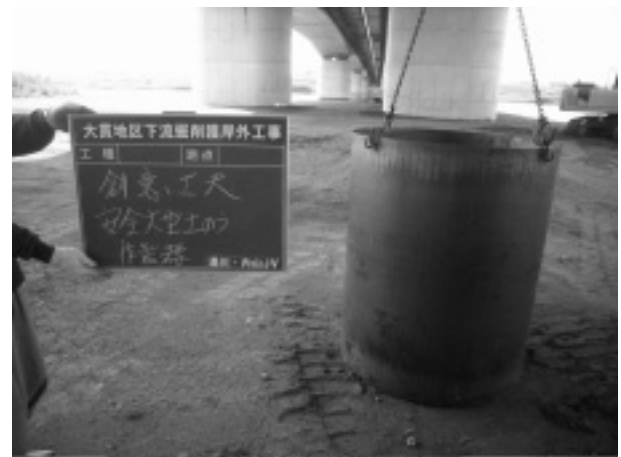
写真-1 大型土のう製作器
