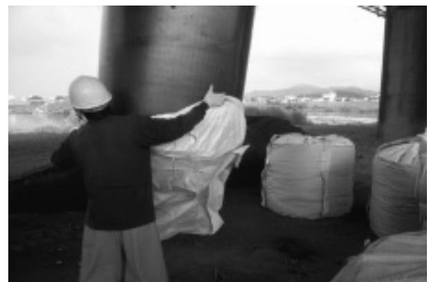
写真-2 土嚢袋のはめ込み
