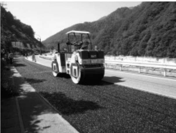
写真-3 転圧状況
