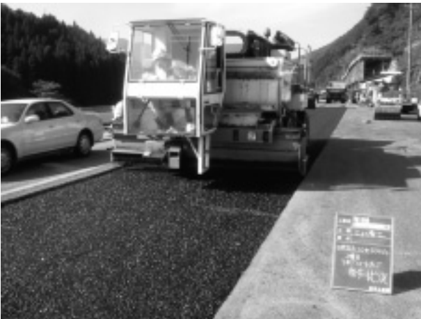
写真-2 プレコート骨材散布状況
