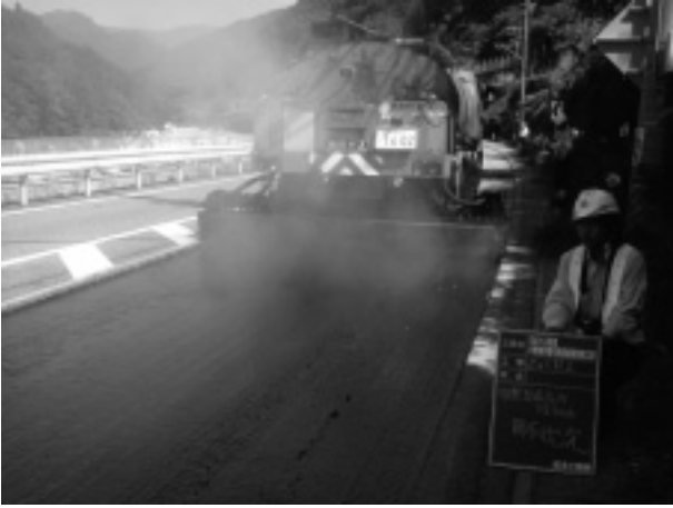
写真-1 加熱型高ゴム化As散布状況
