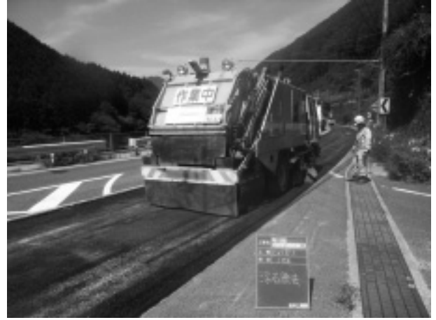
写真-4 浮石除去状況
