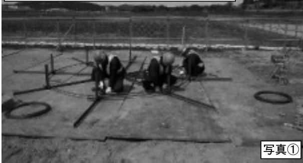
定規を作成し、円形帯鉄筋の組立を実施
