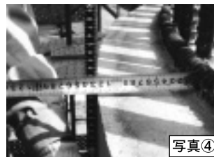
かぶり測定状況
