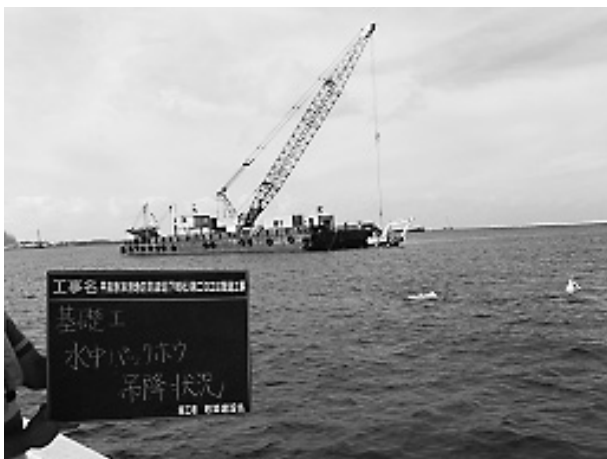
写真-2 水中バックホウ吊降状況
