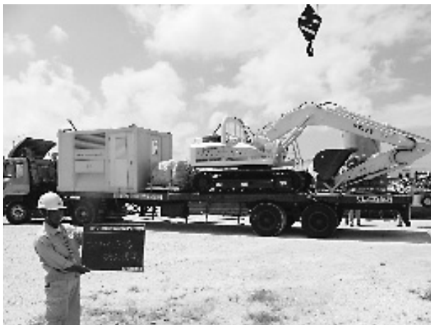
写真-1 水中バックホウ搬入状況
