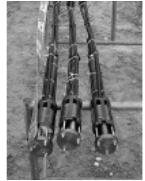
写真-2 IH除去式アンカー
