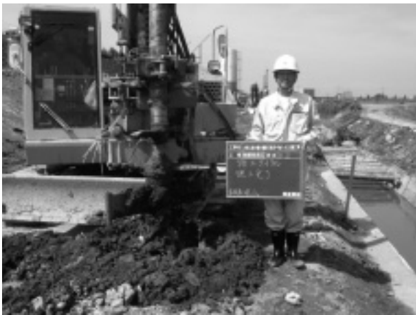
写真-2 地盤改良工施工状況
