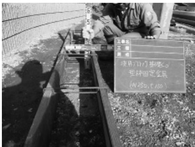
写真-2 型枠固定金具使用状況
