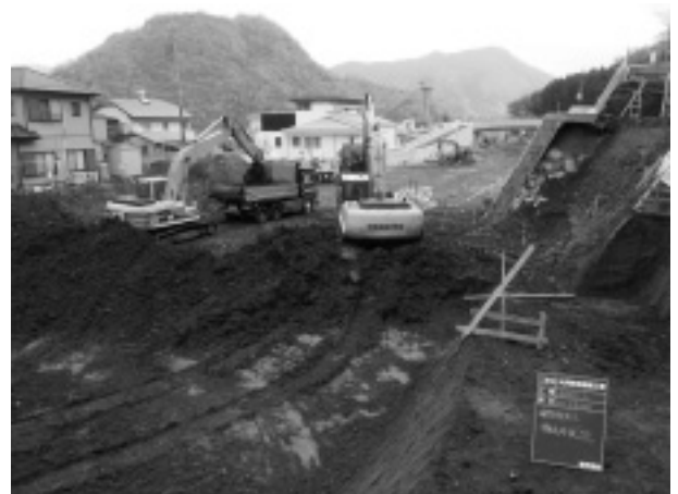
写真-1 現場内搬出土積込状況
