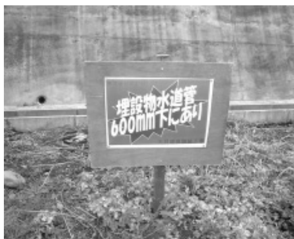
写真-11 右（警告板設置状況）
