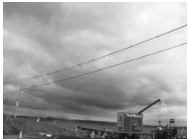
写真-1 防護管取付け完了
