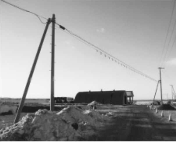
写真-2 三角旗取付け完了
