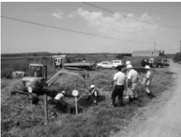
写真-3 水道管試掘状況
