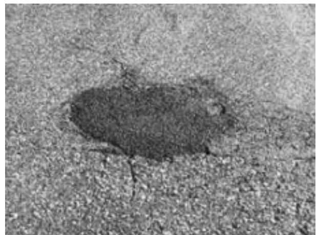
写真-3 1ヵ月後 (パンフレットより)
