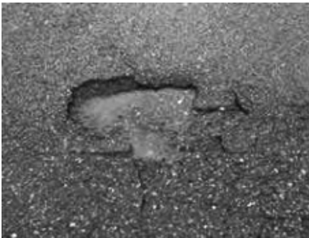
写真-1 施工前 (パンフレットより)
