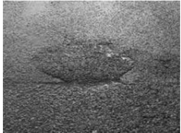
写真-2 施工後 (パンフレットより)
