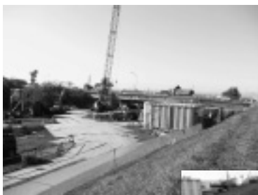
写真-1 仮囲い設置状況
