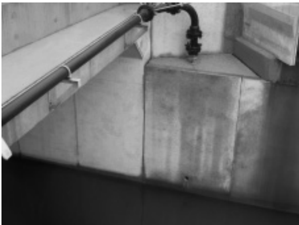
図-1 エラスティックファイラー目地材仕上げ
