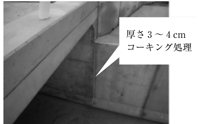
写真-3 構造物とL型のコーキング仕上げ
