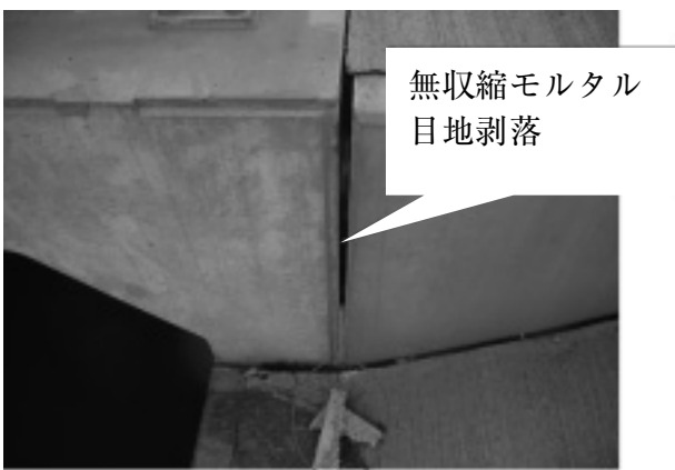
写真-2 モルタルで施工
