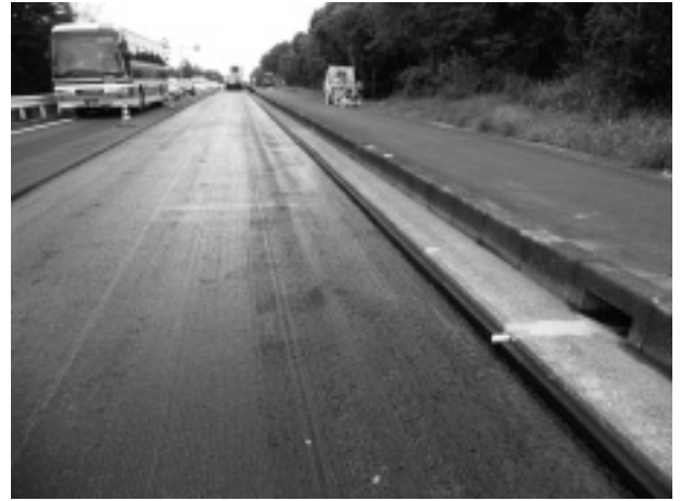
写真-3 基層工舗設前
