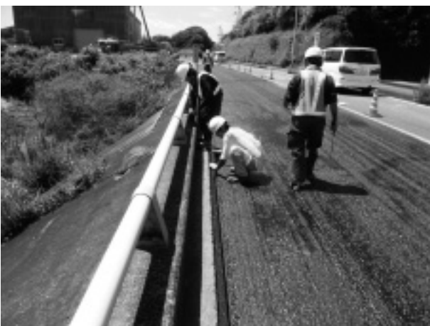
写真-2 導水管設置状況
